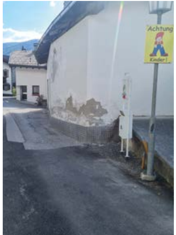
Neue Station in der Schmelzhüttengasse (gegenüber „Palzer“)
