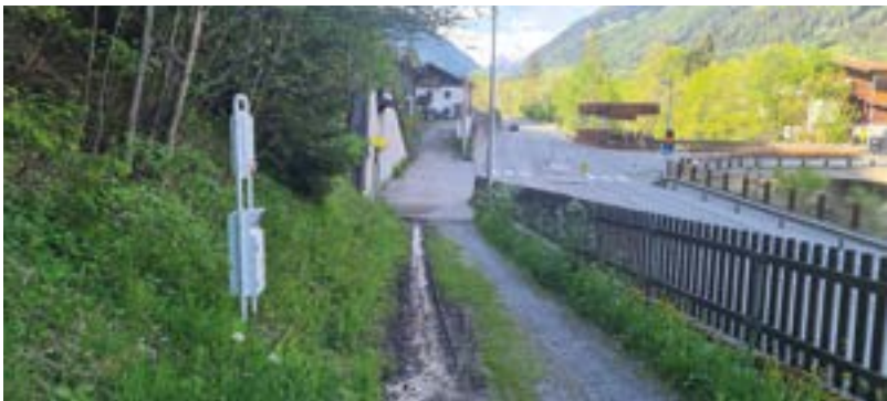
Neue Station im Bereich der Kleebrücke beim Weg zum Kriegerfriedhof - Fotos: Marktgemeinde Fulpmes
