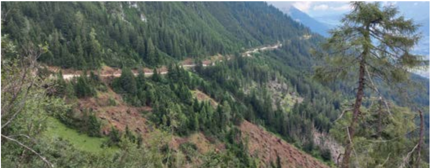
Der neu sanierte Knappenhüttenweg - Foto: Marktgemeinde Fulpmes
