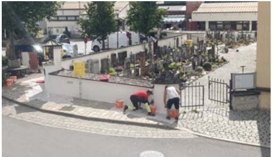
Friedhofsmauer am Dorfplatz erstrahlt in neuem Glanz - Foto: Marktgemeinde Fulpmes
