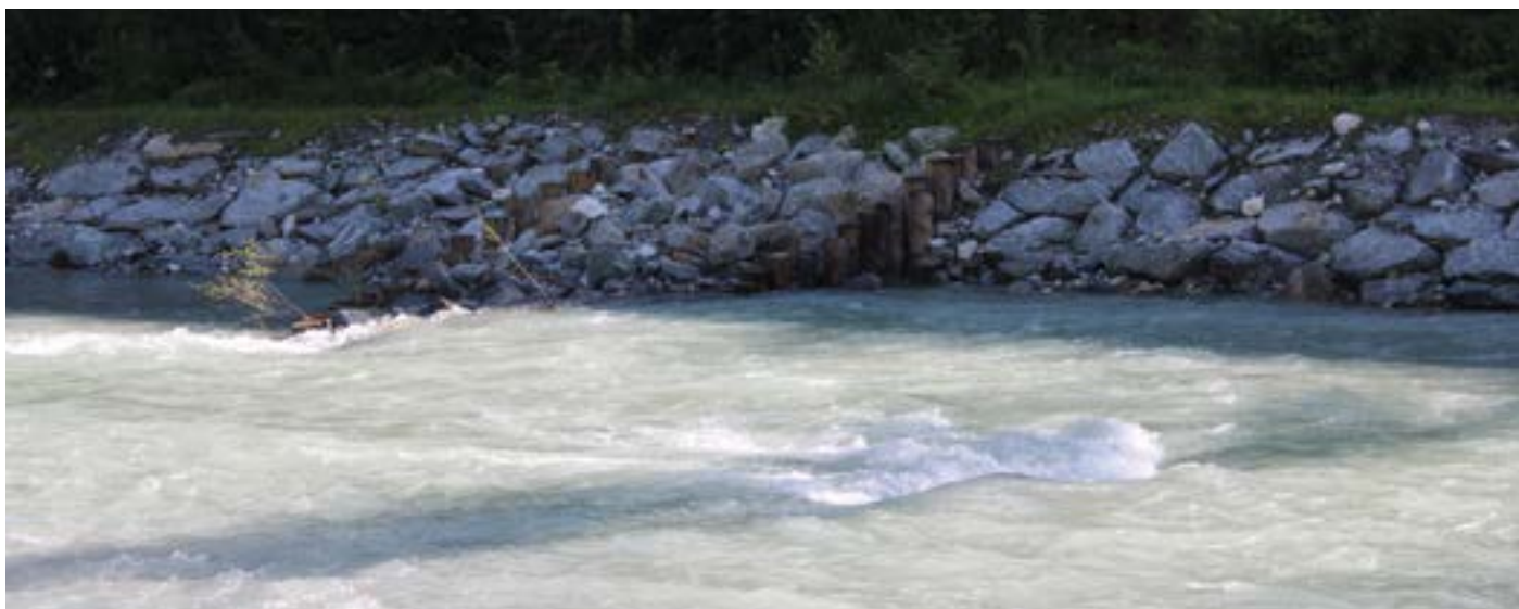
Buhnenbauwerk - Foto: Marktgemeinde Fulpmes
